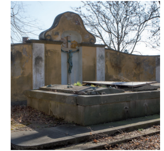
GRUFT Ziegel, Stein gemauert, verputzt, 1925 Schlosspark Marchegg
