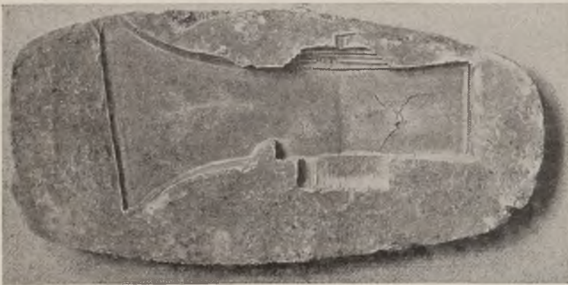
Fig. 16. Gußform für eine Messingaxt. Huzulisch. Galizien.
