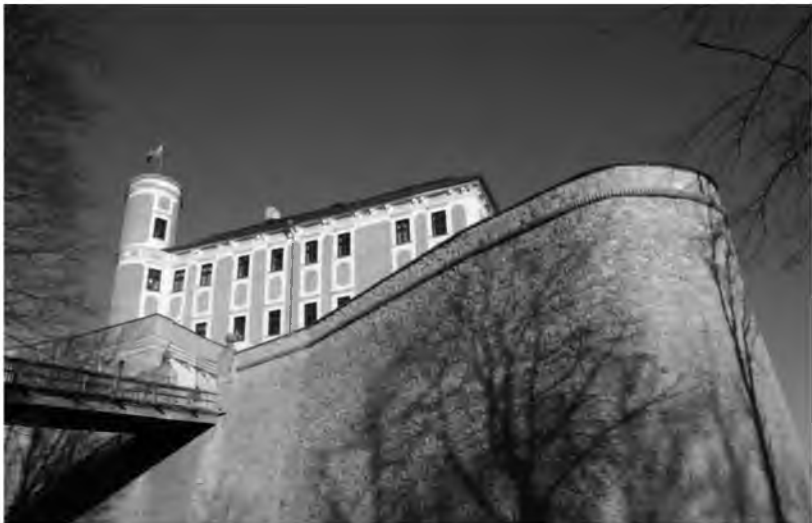
Abb. 10 Südwestbastion, saniert 2009 Foto: K. Krenn
