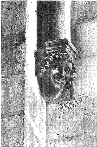
Abb. 3: Reims, südliches Querschiff, Ostturm, Konsolkopf an der Südost-Ecke (Foto: Marburg LA 508/25)
