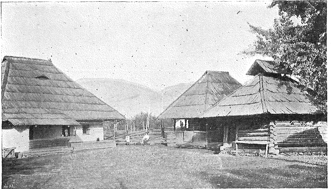
Fig. 2. Bauernhaus samt Nebenanlagen in Kimpolung.
