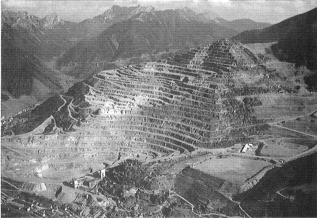
Abb. 12: Der Erzberg heute. Gesamtansicht von Westen gegen Polster und Griesmauer. Ansichtspostkarte.
